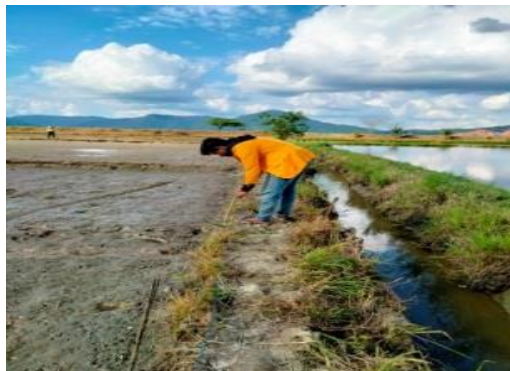
Gambar 5. Pemasangan Tiang Penyangga
