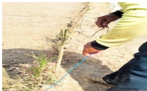
Gambar 6. Pemasangan Pukat Anti Tikus
